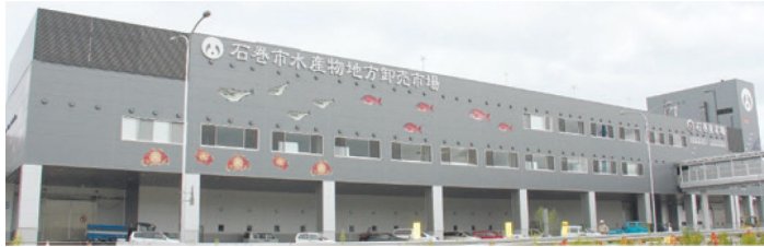
石巻魚市場(平成27年9月完成)
